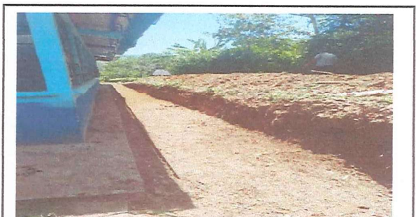
Foto 4: INICIO DEL TRABAJO PARA MURO PERIMETRAL MEDICIÓN Y LIMPIEZA
