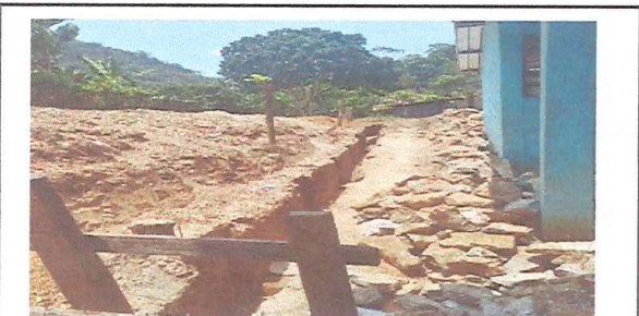
Foto 5: ZANJEOS PARA MURO PERIMETRAL
